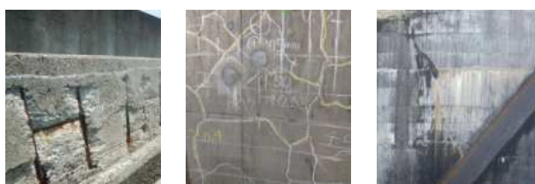
護岸 発電所 ダム
