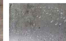
コンクリート表面のはっ水状況
