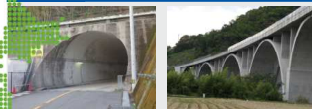
トンネル 道路橋
